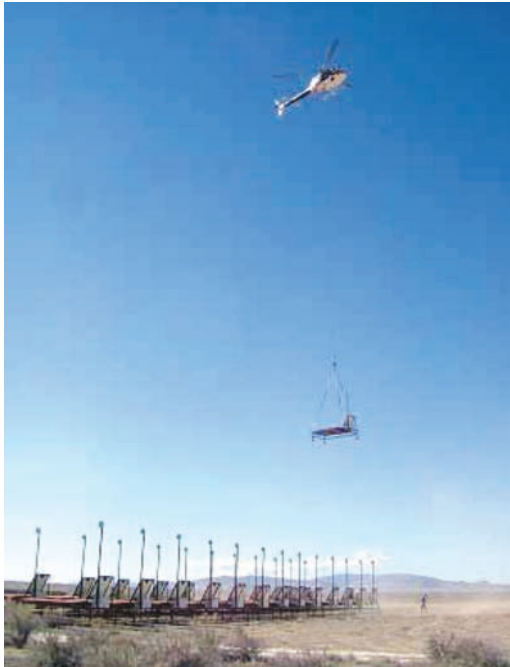
図4 ヘリコプターによる地表粒子検出器の設置風景 (TA サイト内の仮集積場にて)。
