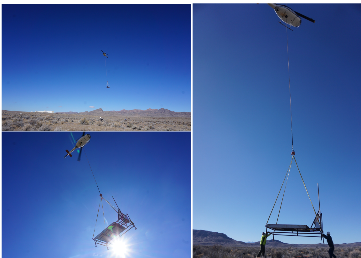
図 3.11: SD を設置している様子。右図:ヘリコプターが下がると同時にソーラーパネルを南に向けて設置する。
