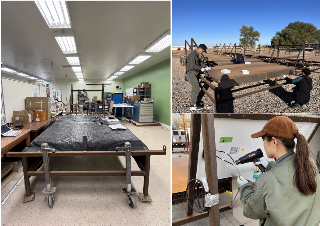
図 3.6: 左：組み立て前に行うテスト中のシンチレーション検出器。右上：屋根を取り付けている様子。右下：ソーラーパネルとバッテリーを繋ぐケーブルを取り付けている本論文の著者である。
