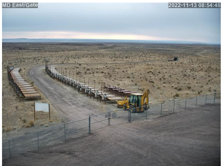
図 3.8: 全 50 台の SD を TALE FD 付近に移動完了後の様子。
