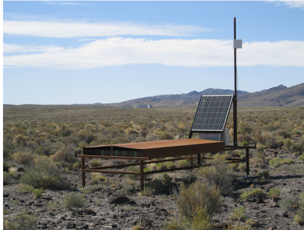
図 2.17: TALE Surface Detector。中心奥には TA MD ステーションと TALE ステーションが写っている。
