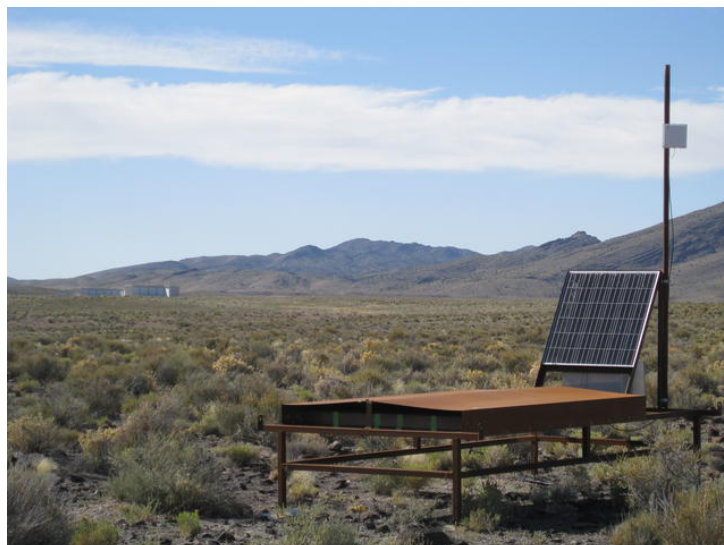
図 2.8: TALE-SD. 茶色の屋根の下にシンチレータボックスが格納されている. 写真中央左寄り遠くに MD, TALE-FD ステーションが見える.
