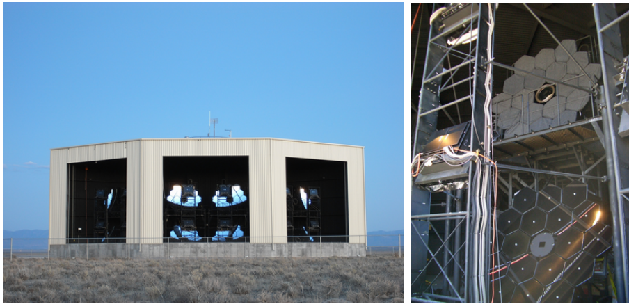
図 3.2: FD ステーションの概観 (左) とステーション内の望遠鏡 (右)
