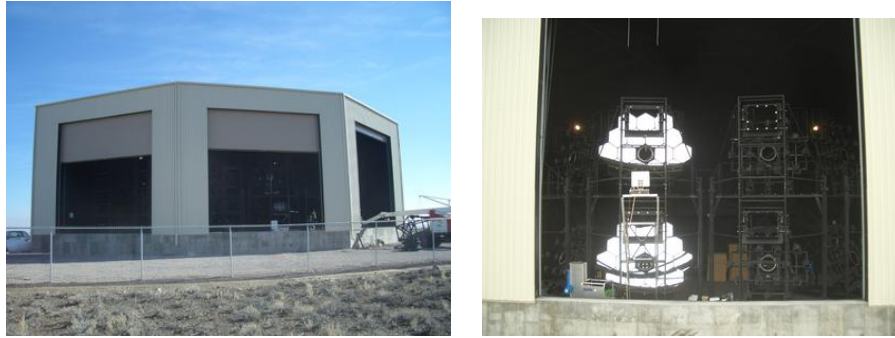
図 3.8: 左：FD ステーション (Black Rock Mesa)、右：内部に設置された FD
