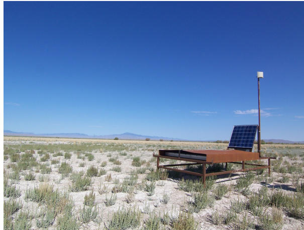
図 3.21: 現地 (ユタ州) に設置された地表検出器
