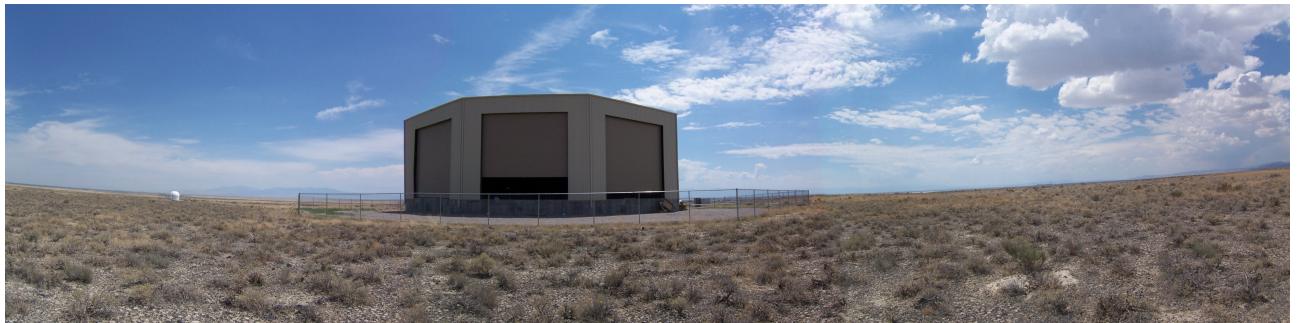
図 3.2: FD ステーション (Black Rock Mesa サイト) の外観
