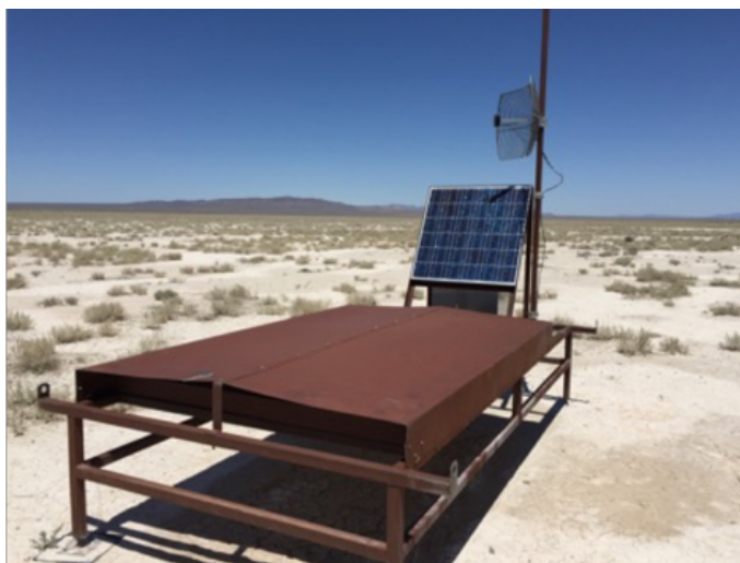
図 2.2: SD ステーション外観
