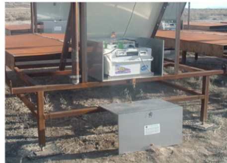
図 2.6: ソーラーパネル裏側にあるステンレスボックスとその内部。(カバーを外したところ).
