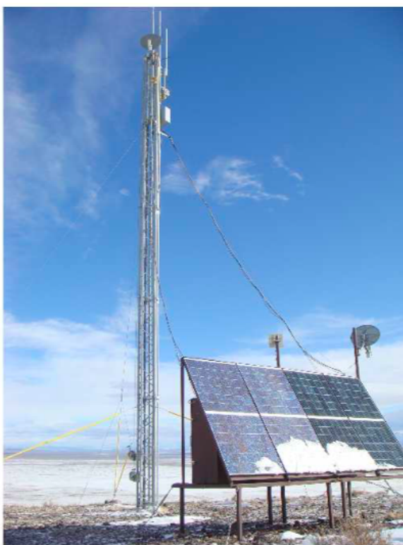
図 2.8: LR 通信塔の外観, 太陽光電池パネルにより電源供給している。
