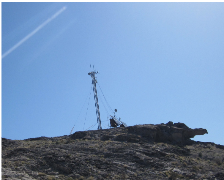
図 3.2.4: 地表粒子検出器の通信塔
