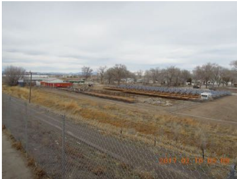
図 6.3: CRC の東側の土地。左奥に見える白みがかっている建物が CRC で、手前には 2017 年 2 月 10 日の時点で 173 台の SD が保管されている。
