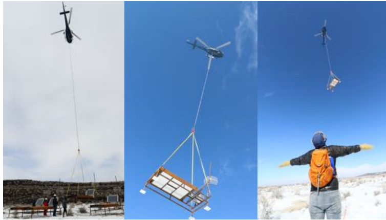
図 6.7: SA に仮置きした SD はヘリコプターによって指定された座標の設置場所まで運ばれる。
