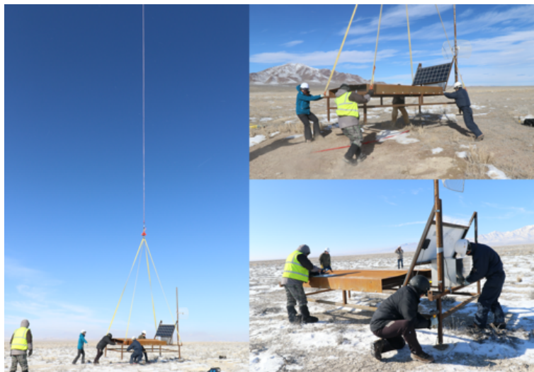
図 6.8: 別のヘリコプターで向かった数名が先に設置地点で待機しており、下ろした SD を決められた地点に固定する。
