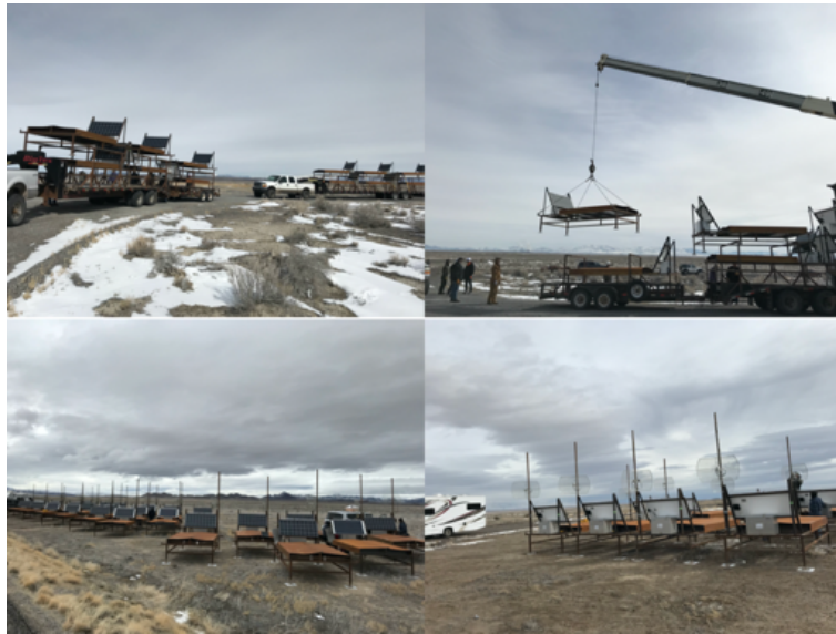
図 6.4: SD を SA へ移動した作業の写真。(左上)SD をトレーラーで運んで SA へ向かっているところ。(右上) クレーンを用いて SA に到着した SD を下ろしているところ。(左下)SA への仮置きが完了した SD。(右下) 故障がないかテストを行ったのち各 SD にアンテナを取り付けた。
