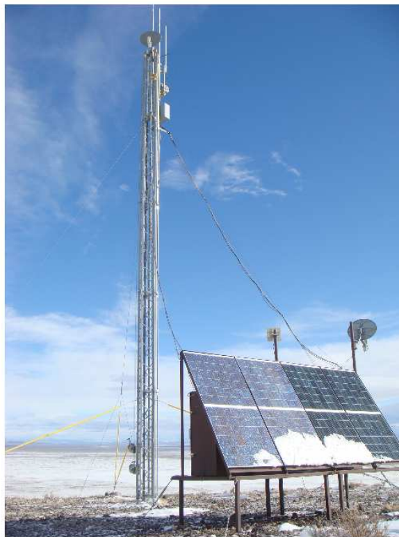
図 2.5: LR 通信塔の外観．太陽電池パネルにより電源供給している．
