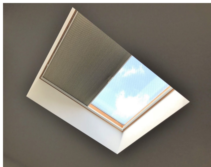
図 3.13 セイキ社製 ハニカムサーモスクリーン
